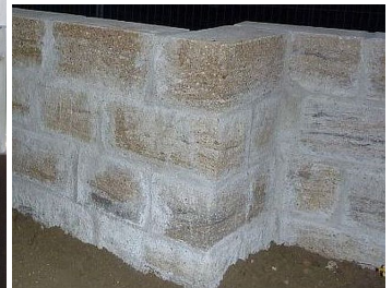
Bild 4: Betonsteine werden gerne dem Naturstein nachgebildet, erreichen aber nie die Schönheit von Original-Granit, Sandstein, Travertin oder Kalkstein . Wenn dazu noch schlampig und unsauber verfugt wird, müssen sich Bauherren oft jahrelang über hässliche Mörtelrückstände in den rauen Betonsteinen ärgern.
