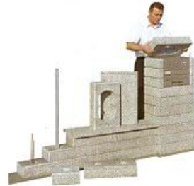
Mauern mit Torsäulen inklusive Briefkästen lassen sich schnell und einfach erstellen.
